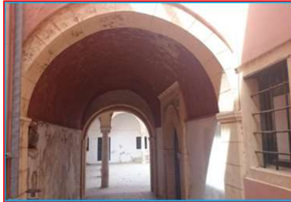
لوحة (66)- تسقيف قبوي طولي ذو شكل عقد نصف دائري بقلعة سرايا الحمراء بطرابلس (أرشيف الباحثان)
