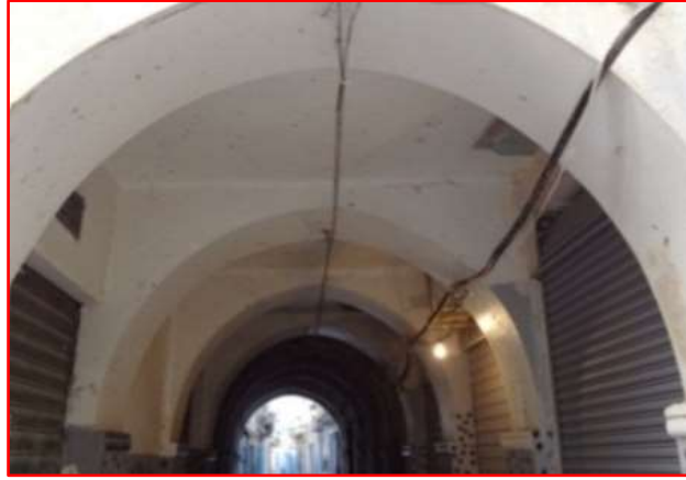
لوحة (36) - تسقيف بأحد الشوارع باستخدام تقنية الكمر (أرشيف الباحثان)
