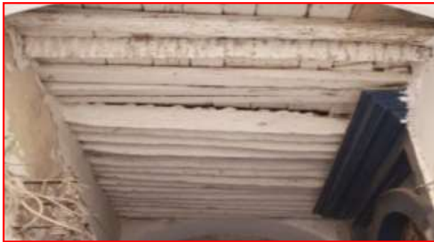
صورة (11) استخدام خشب النخيل في تغطية الوحدات المعمارية بالمدينة القديمة طرابلس (أرشيف الباحثان)
