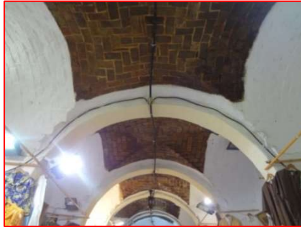
لوحة(78)- العقود الإنشائية الحاملة للتسقيف بالأقبية المتقاطعة بسوق الرباع الجديد (اللفة) (أرشيف الباحثان)
