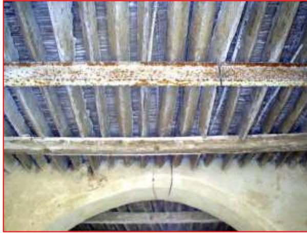
لوحة (10) - الكمرات الحديدية و العوارض الخشبية لتحميل السقف (أرشيف الباحثان)
