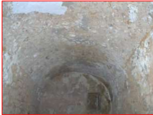
لوحة (58) - نظام التسقيف بالقبو الطولي مكسو بملاط (أرشيف الباحثان)
