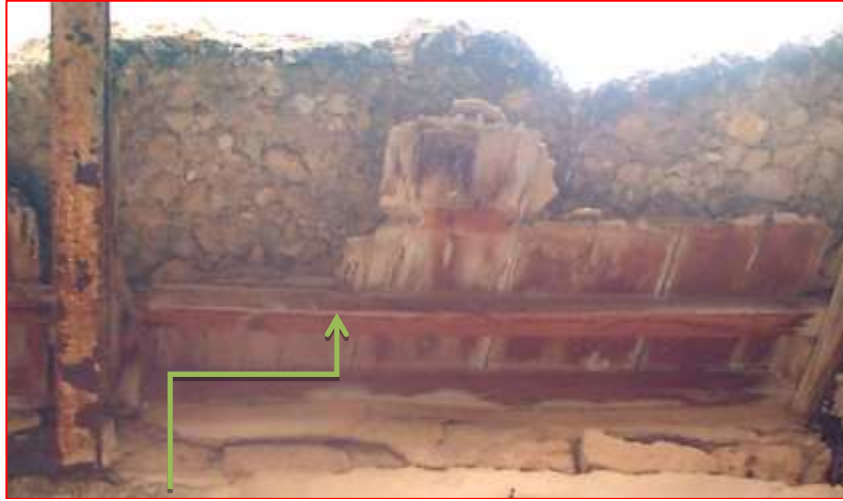
لوحة (6)- استخدام الخرسانة (المرش) في طبقة الكرسان العربي بأعمال التسقيف (أرشيف الباحثان)
