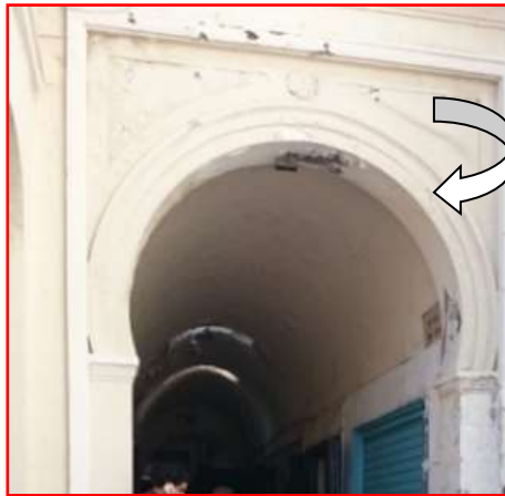
لوحة (70) - تسقيف قبوي طولي ذو شكل العقد الموتور المذنب (أرشيف الباحثان)
