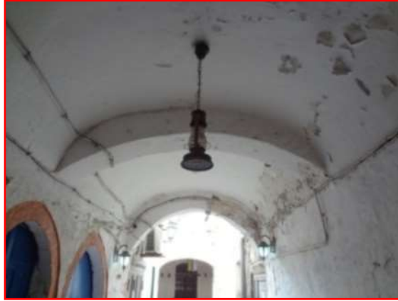
لوحة(67)- تسقيف قبوي طولي ذو شكل موتور، أزقة المدينة القديمة بطرابلس(أرشيف الباحثان)
