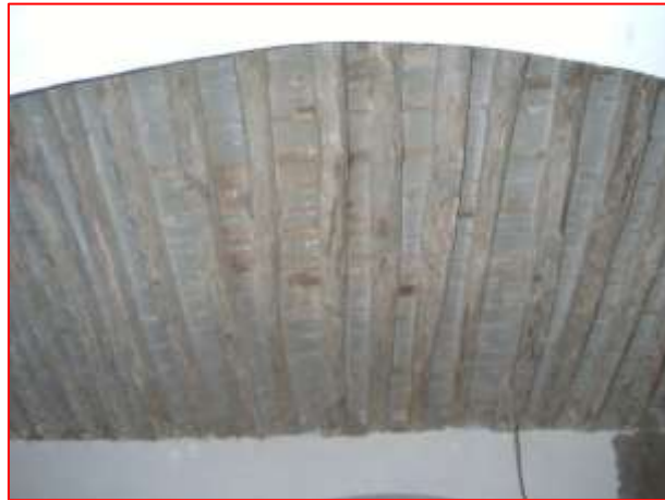
لوحة (7) - استخدام خشب الزيتون في التسقيف (أرشيف الباحثان)
