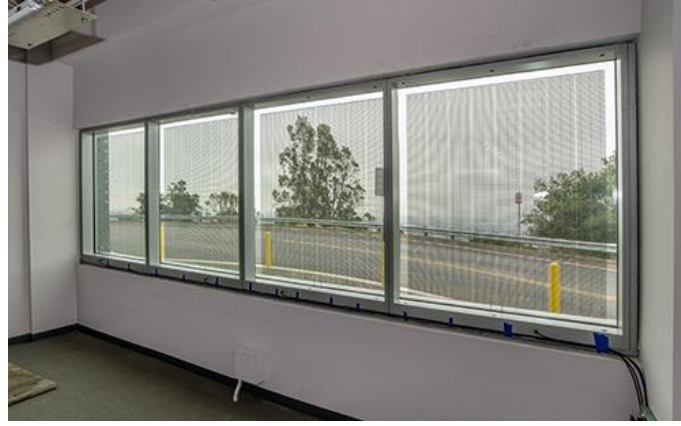
شكل (15) الخلايا الكهروضوئية في تكامل مع تصميم النوافذ (46) .
